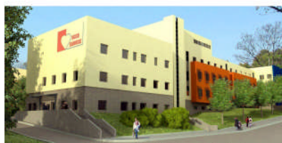
obiekt nowego Centrum Chorób Serca w trakcie wyposażania
